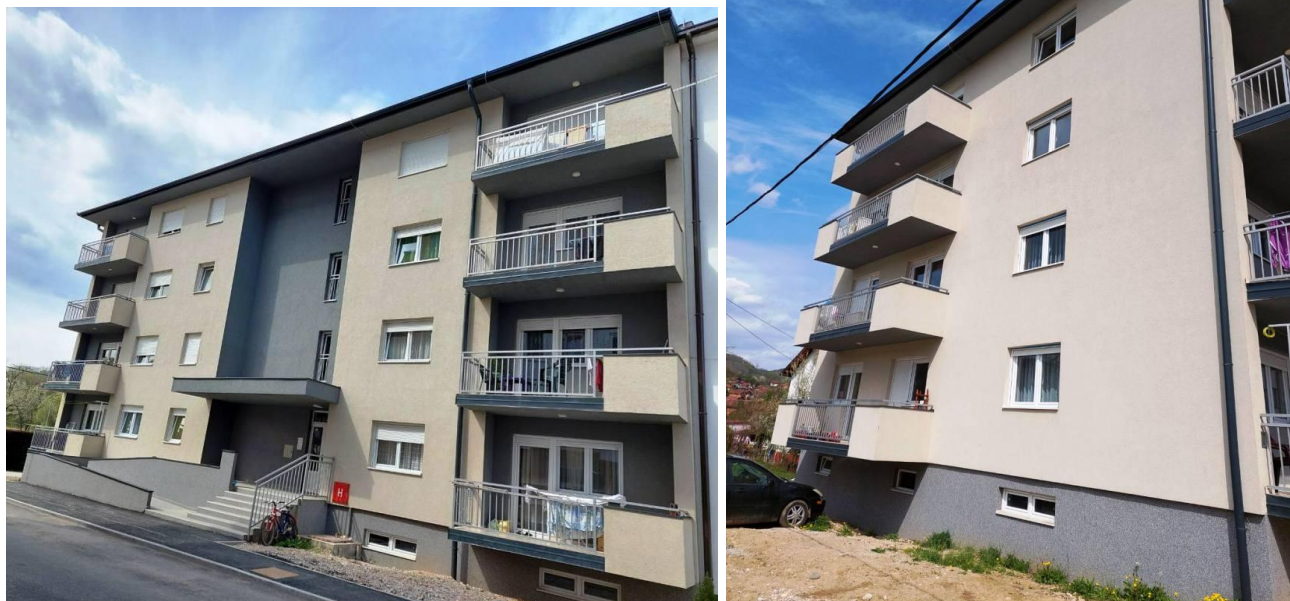
Слика 1. Зграда социјалног становања
